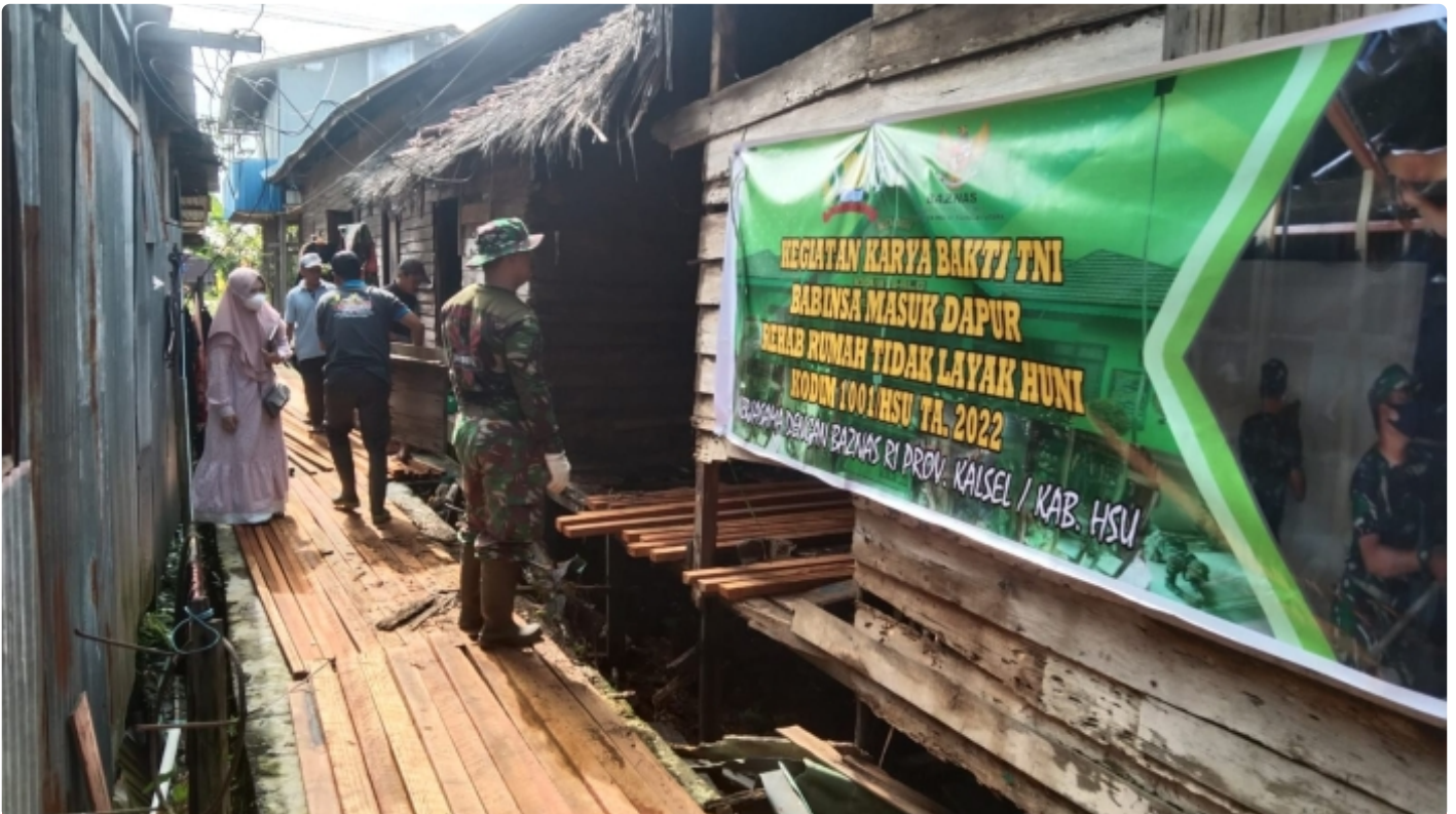
Kodim 1001/HSU-Balangan Bekerja Sama Dengan Baznas Rehab 10 Rumah Di Kab. HSU
